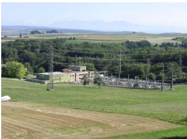
*Vue plongeante sur la Romande Énergie.* On y voit le bâtiment principal avec les câbles électriques à haute tension qui vont desservir par la suite toute la population du canton de Vaud. Le second bâtiment se trouve au bord de la rivière pour permettre à l'eau qui se trouve dans la conduite forcée d'avoir plus de vitesse grâce à la chute et ainsi finir par créer l'électricité.
